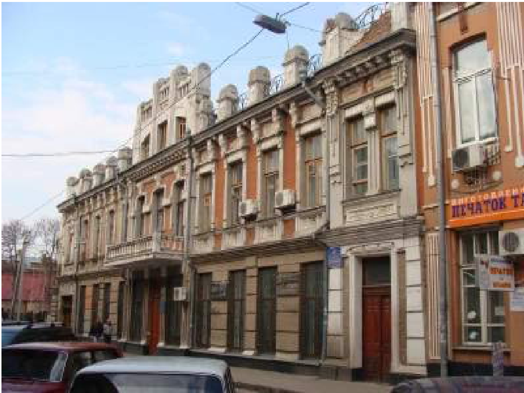
Будинок громадського призначення вул. В'ячеслава Чорновола, 38
