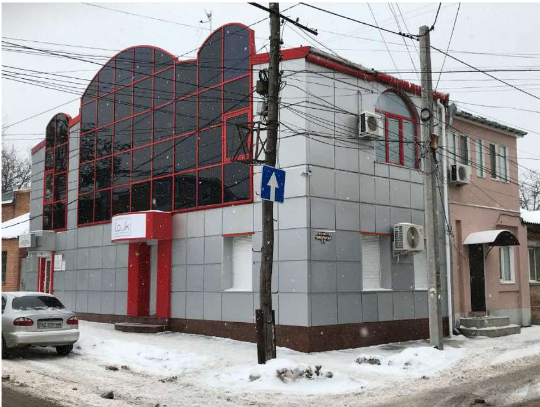
Будинок житловий (пам'ятку перебудовано) вул. Шульгіних, 19
