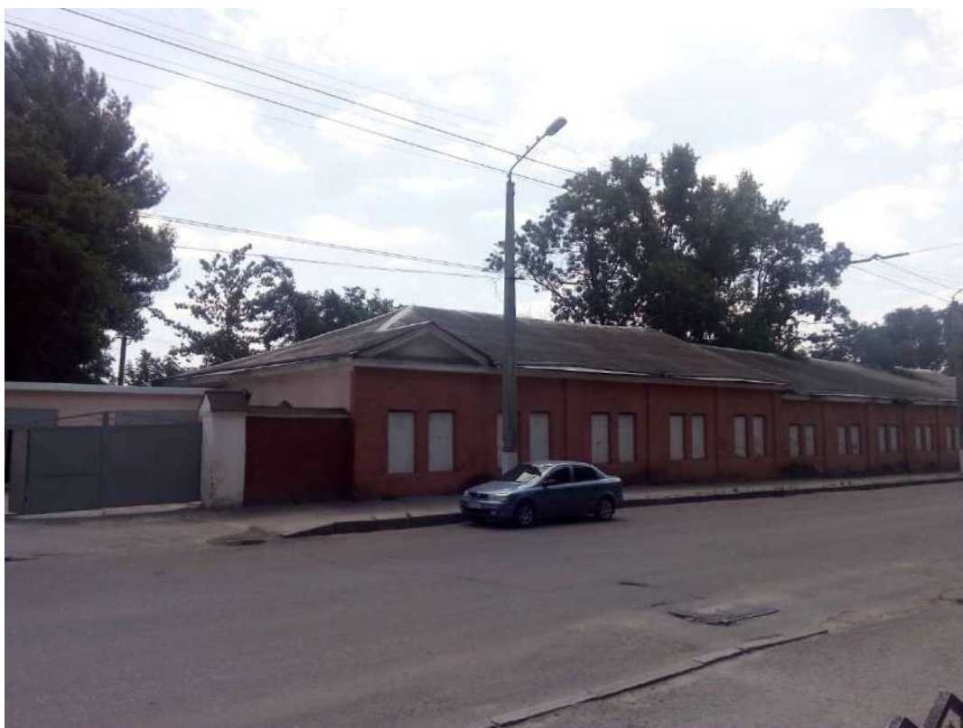
Комплекс споруд колишніх казарм (2 споруди). Казарма вул. Шевченка, 3
