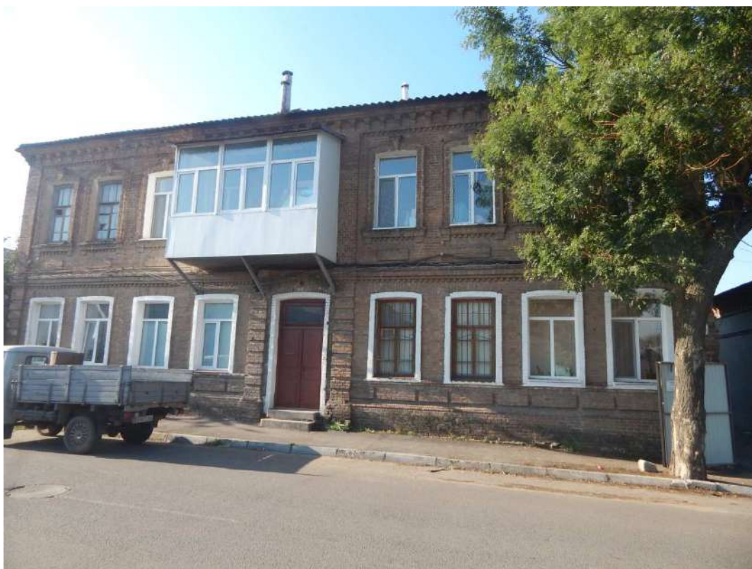
Будинок житловий вул. Покровська, 30 (2-поверховий)
