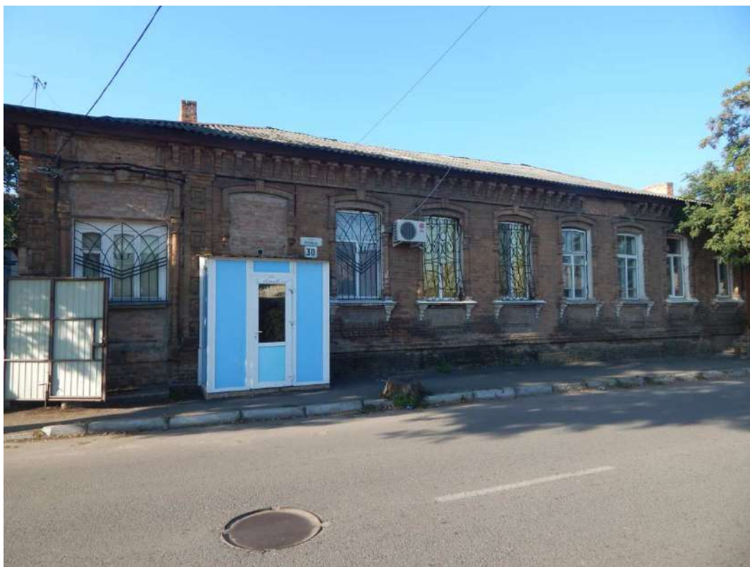
Будинок житловий вул. Покровська, 30 (1-поверховий)
