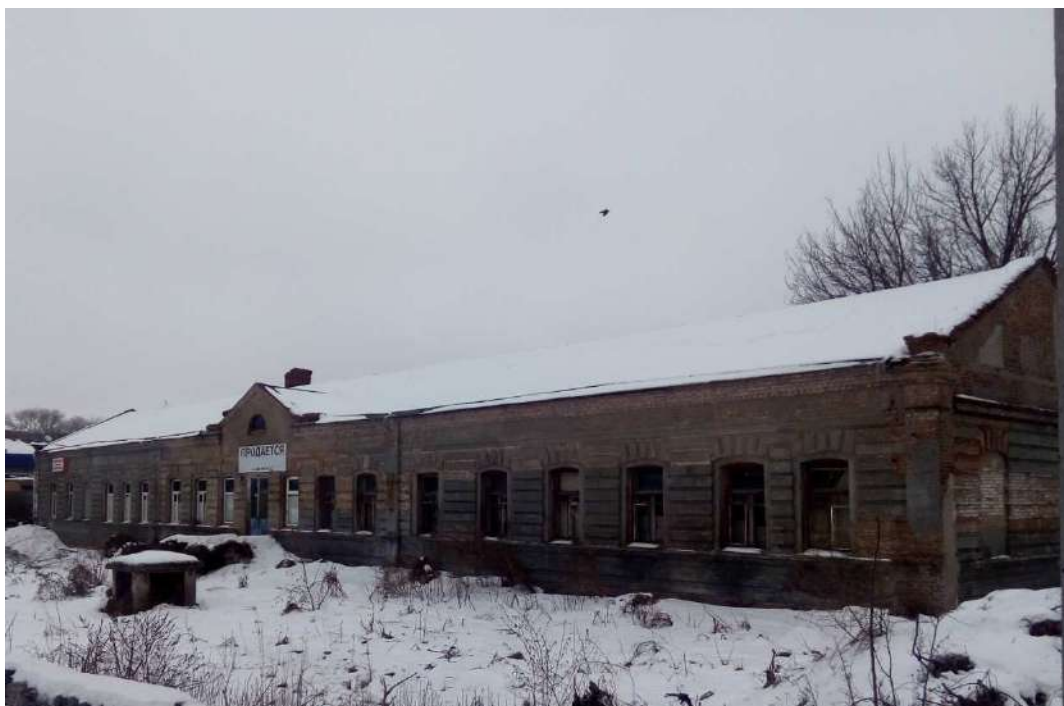
Будинок громадський вул. Покровська, 48
