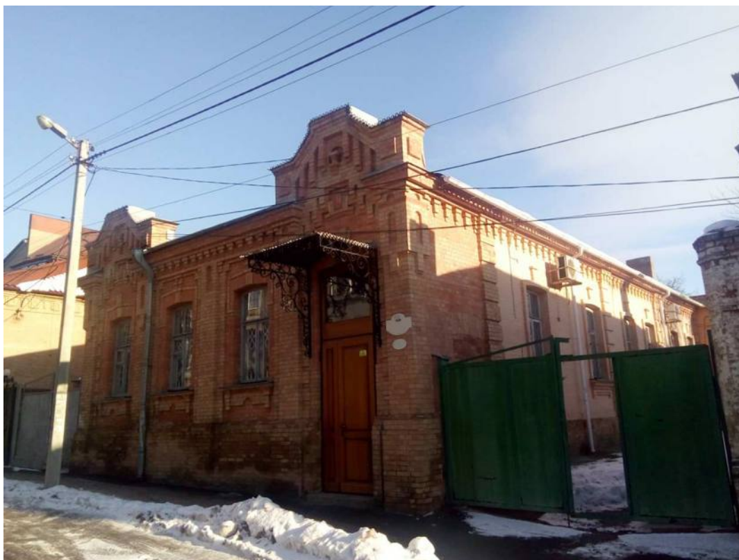
Будинок житловий вул. Пашутінська, 39
