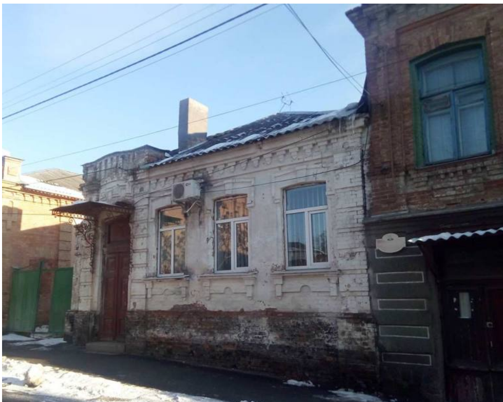
Будинок житловий вул. Пашутінська, 41
