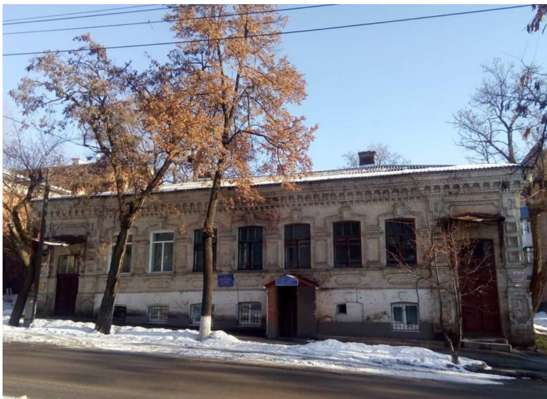
Будинок житловий вул. Пашутінська, 13
