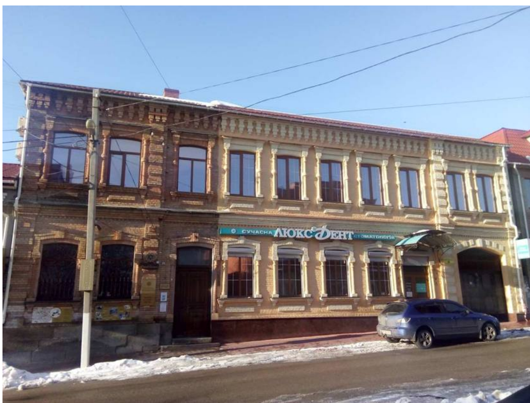
Будинок житловий вул. Пашутінська, 36
