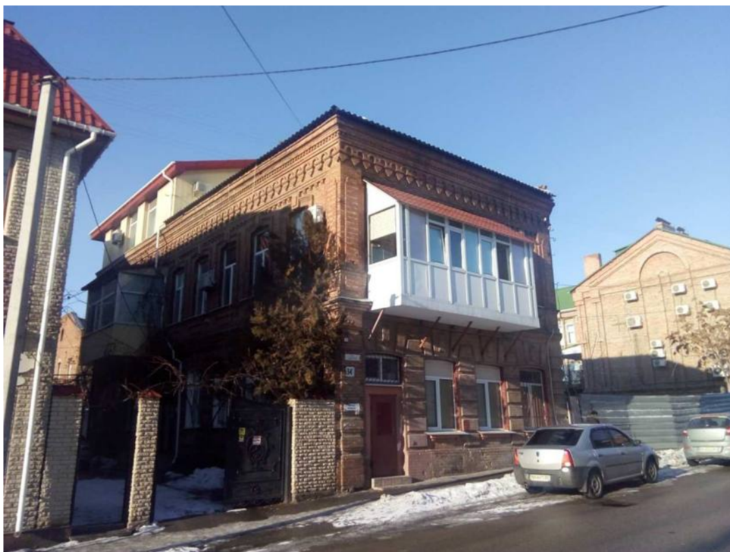
Будинок житловий вул. Пашутінська, 34
