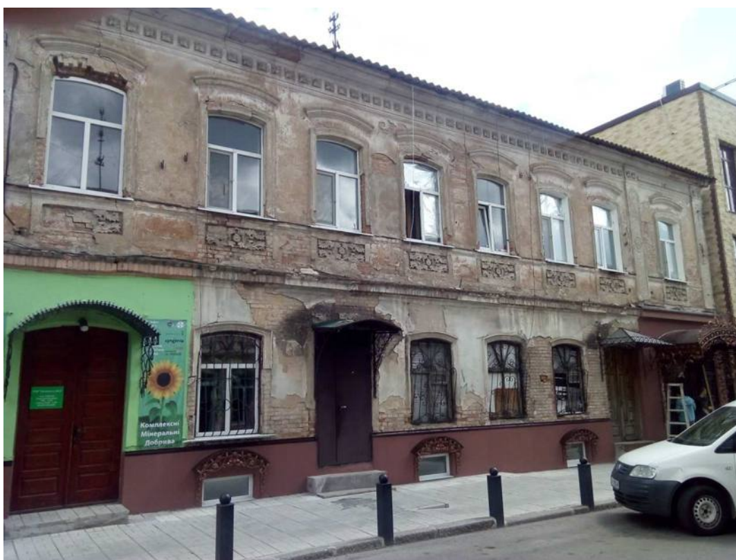
Будинок житловий вул. Пашутінська, 61
