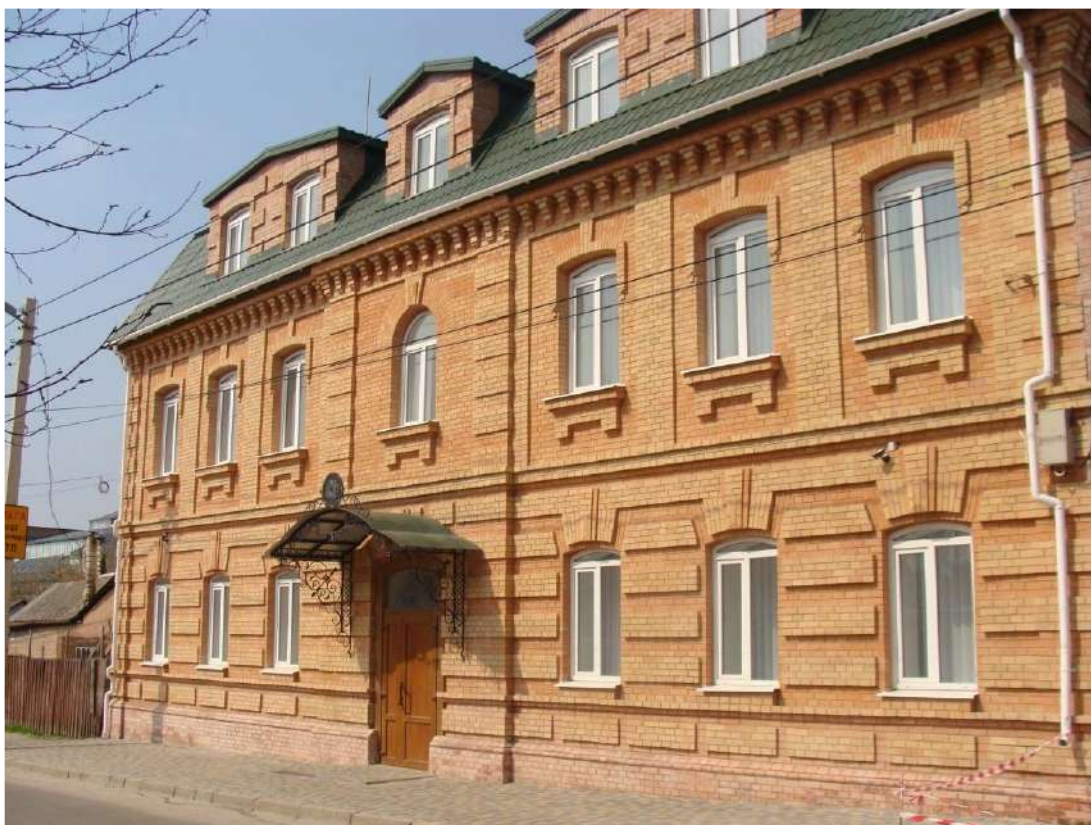
Корпус заводу „Цукрогідромаш” вул. Михайлівська, 64
