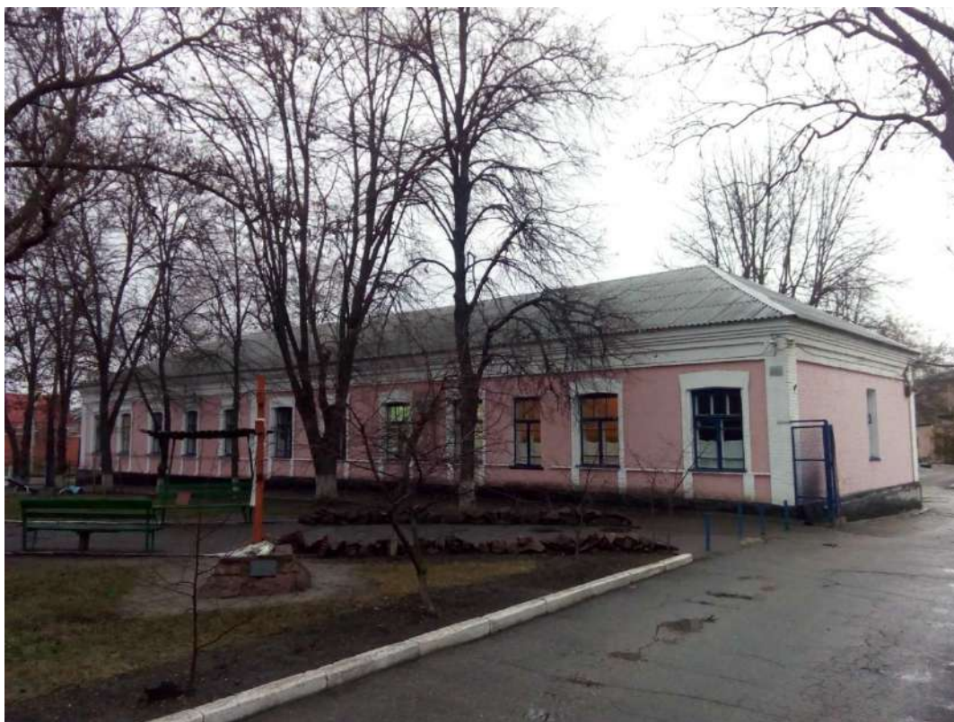
Комплекс будівель колишньої богодільні, побудованої на кошти купця Д.І.Купченка. Корпус лікувальний вул. Габдрахманова, 18/29
