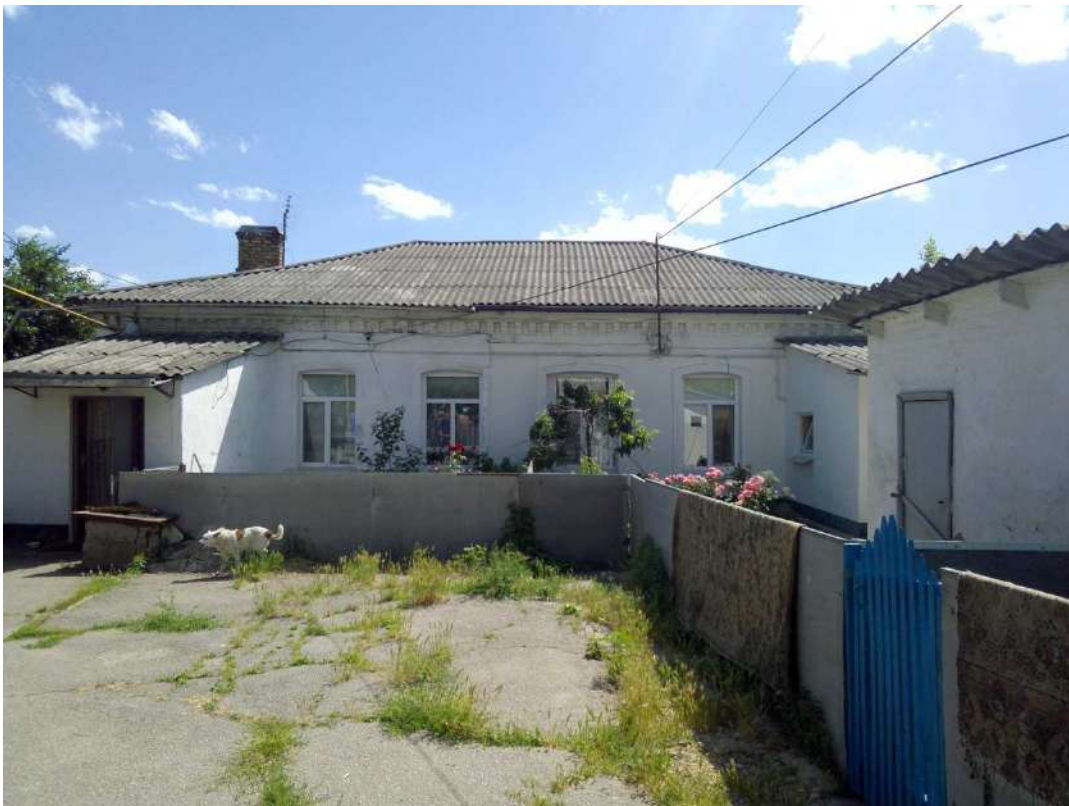
Будинок житловий вул. Гоголя, 128 (у дворі)
