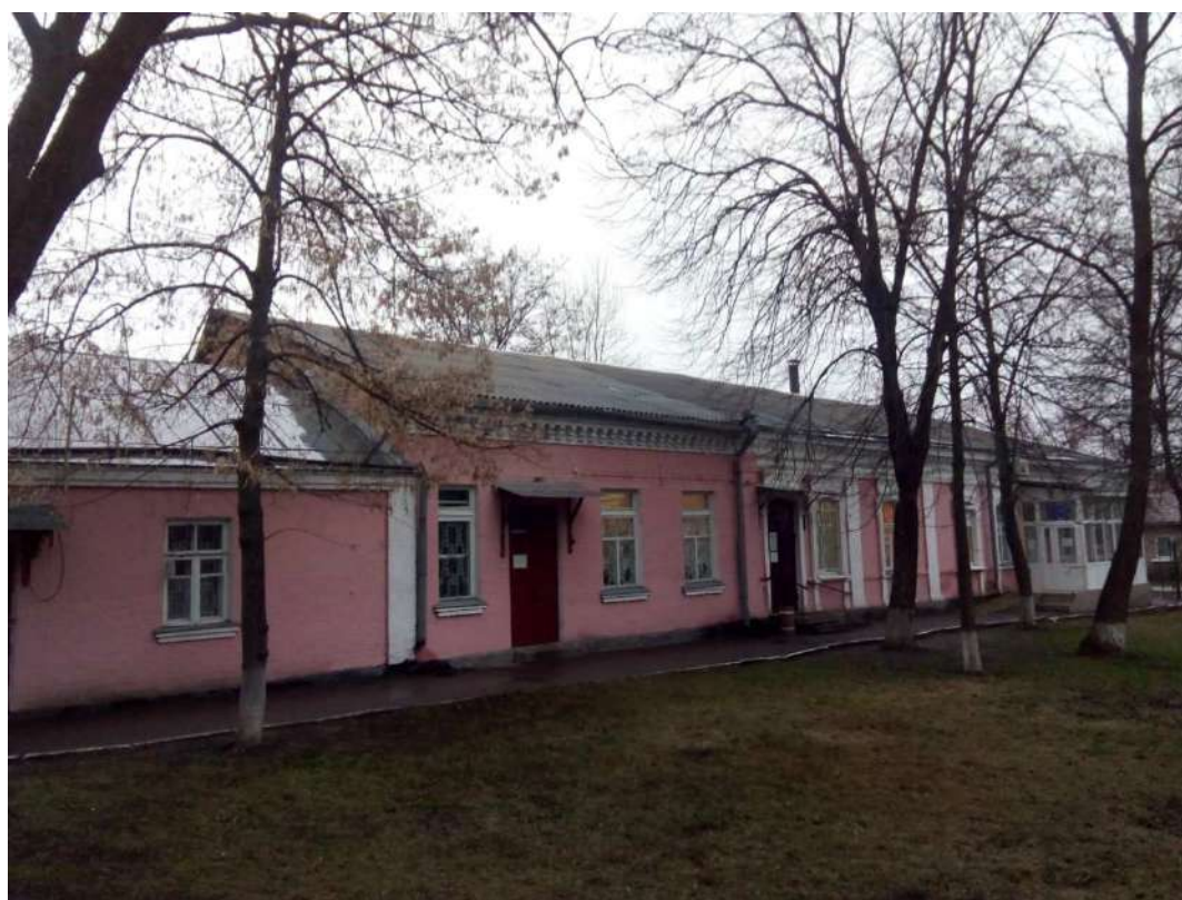
Комплекс будівель колишньої богодільні, побудованої на кошти купця Д.І.Купченка. Корпус лікувальний вул. Габдрахманова, 18/29
