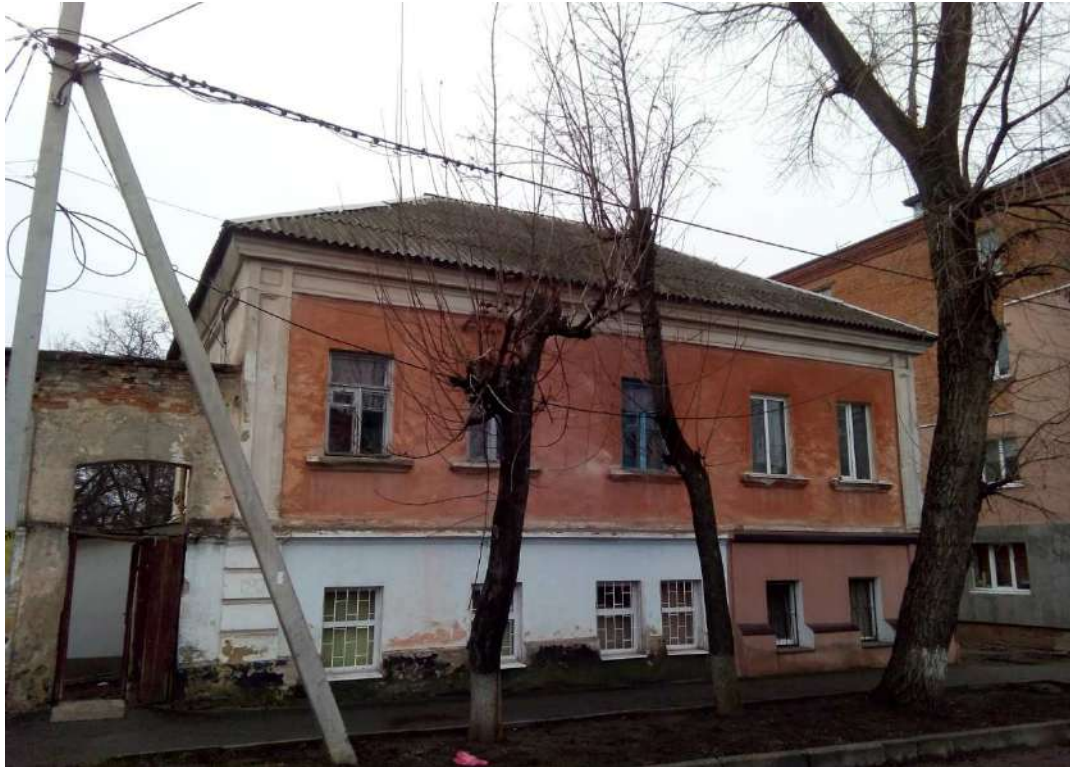
Будинок житловий вул. Гагаріна, 18 (2-поверховий)
