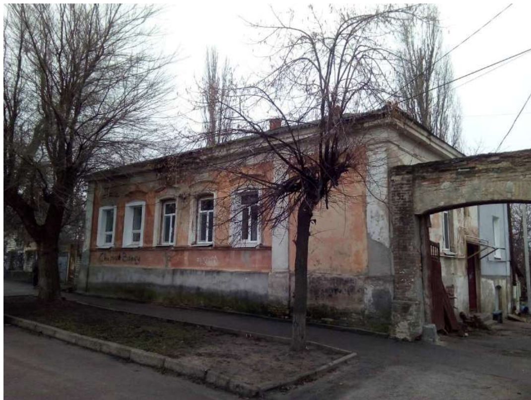
Будинок житловий вул. Гагаріна, 18 (1-поверховий)
