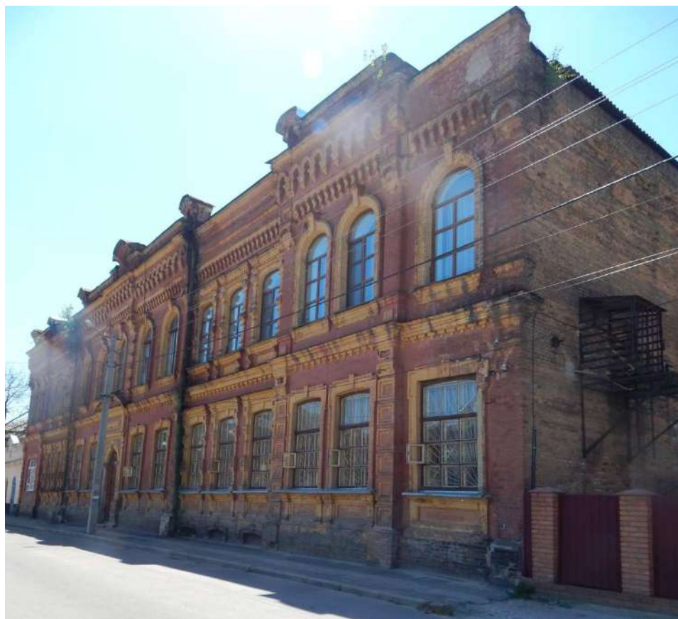
Будинок талмуд-тори вул. Гоголя, 54
