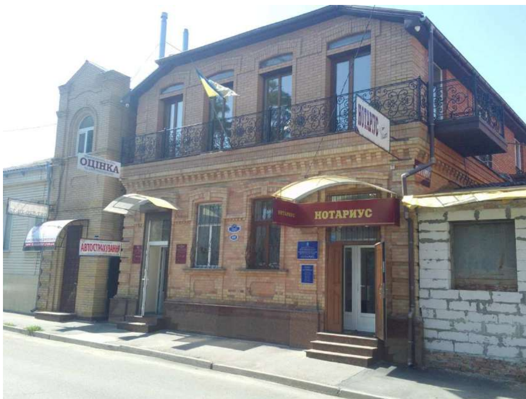
Будинок житловий вул. Гоголя, 90/61 (вул. Арсенія Тарковського)
