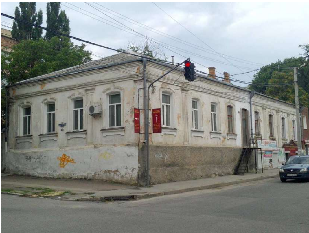
Будинок житловий вул. Гоголя, 105/59 (вул. Арсенія Тарковського)
