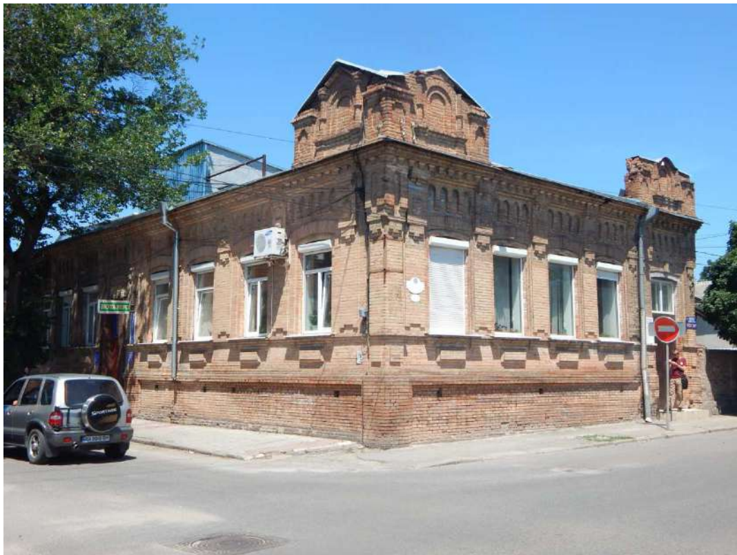
Будинок житловий вул. Декабристів, 22/75 (вул. Гоголя)
