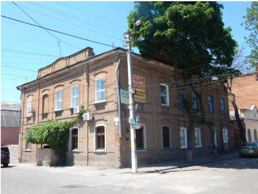
Будинок житловий вул. Декабристів, 24/56 (вул. Гоголя)
