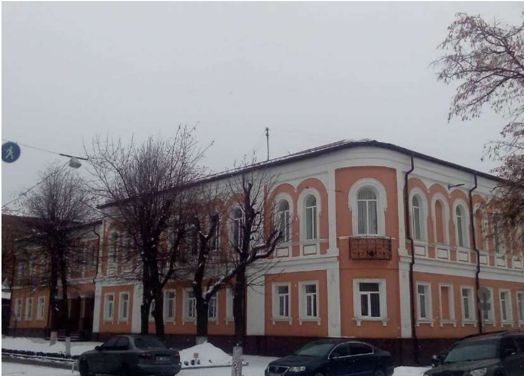
Будинок землевпорядної комісії вул. Дворцова, 6/7 (вул. Нейгауза)
