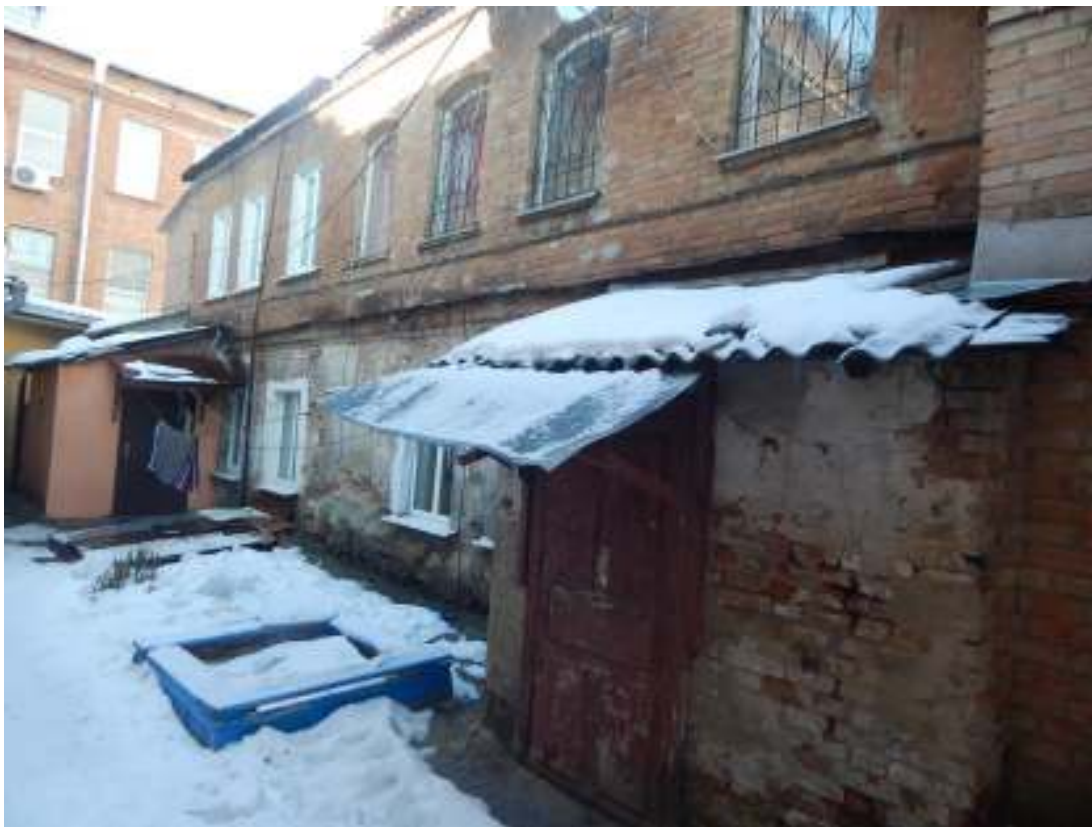
Будинок житловий вул. Віктора Чміленка, 57 (у дворі)
