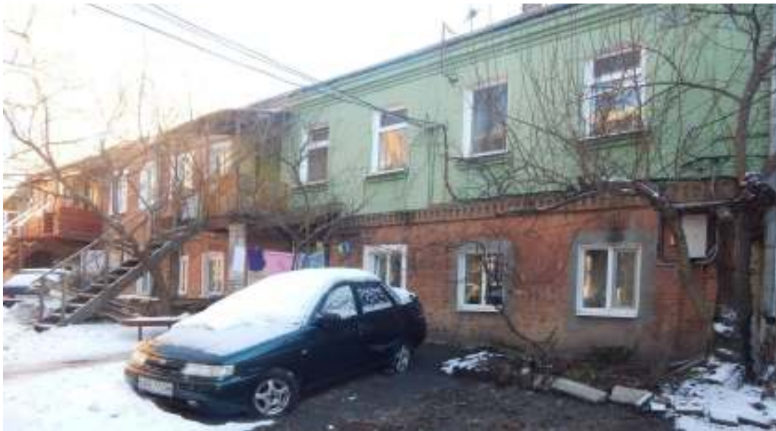
Будинок житловий вул. Віктора Чміленка, 61 (у дворі)
