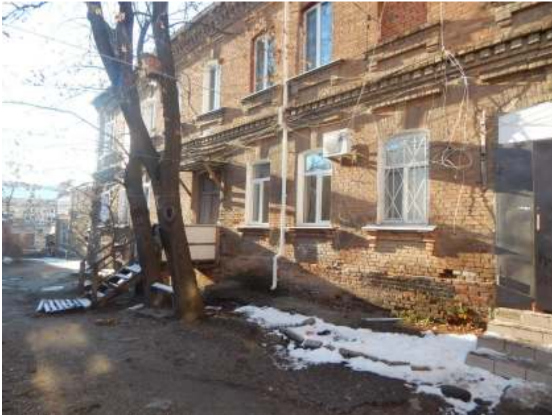
Будинок житловий вул. Віктора Чміленка, 59 (у дворі)
