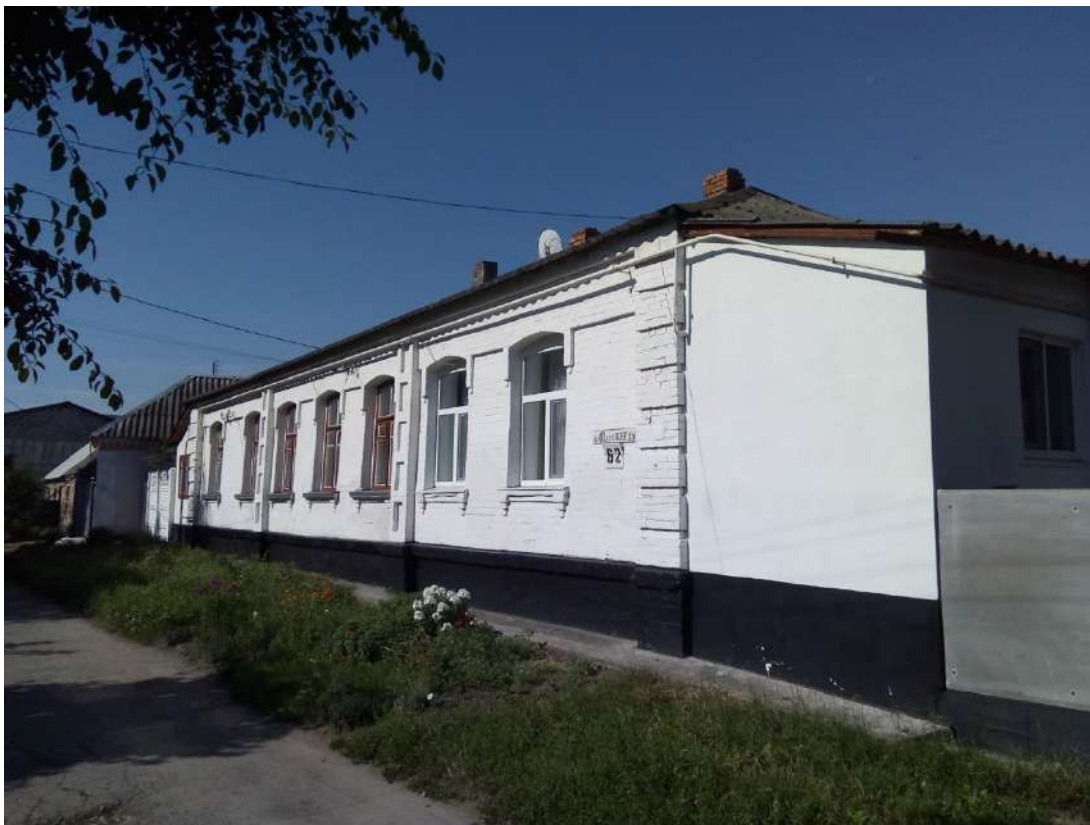
Будинок житловий вул. Бобринецький шлях, 62
