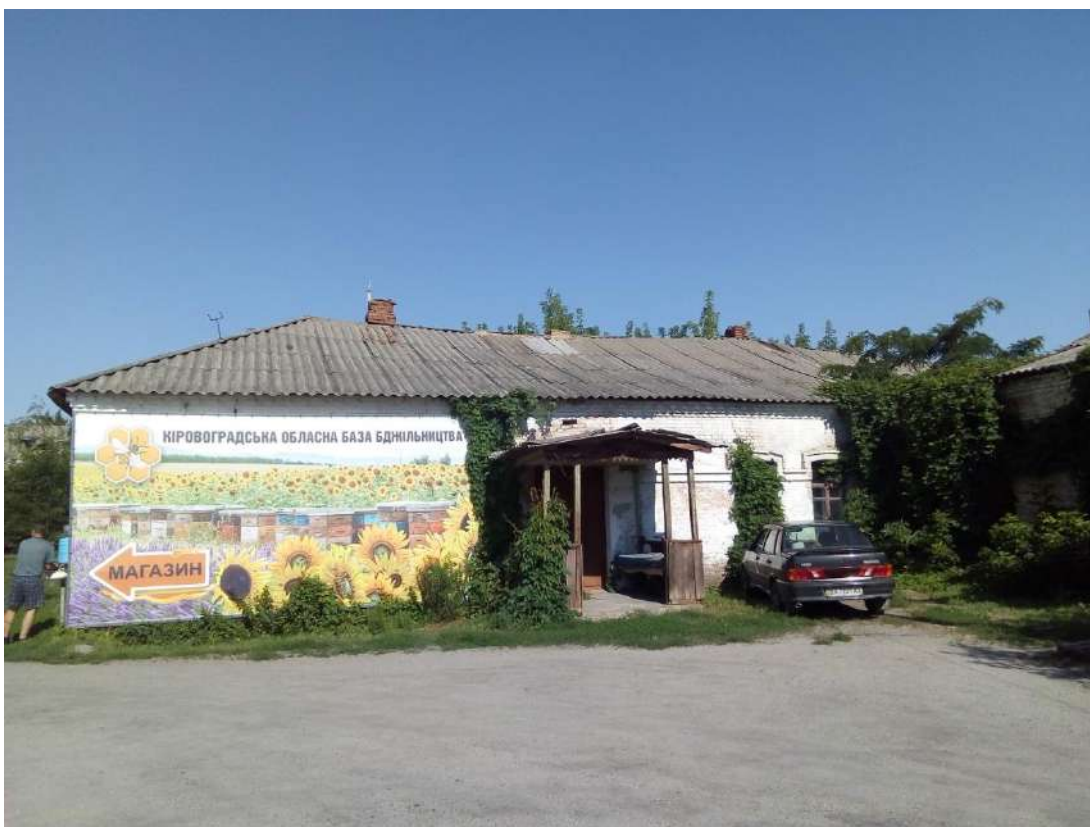
Будинок житловий вул. Бобринецький шлях, 56
