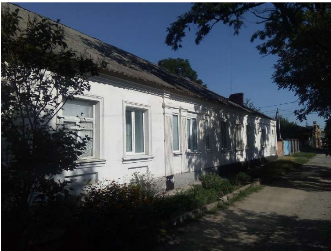
Будинок житловий вул. Бобринецький шлях, 26/33
