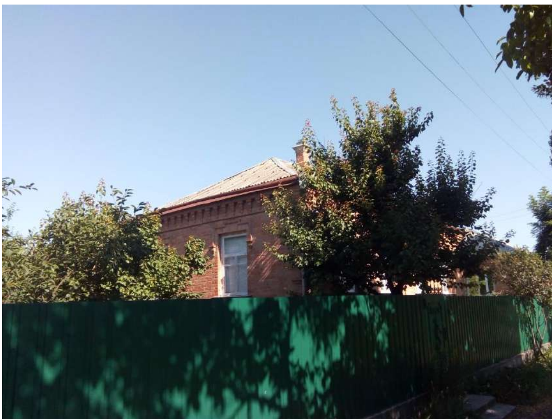
Будинок житловий вул. Бобринецький шлях, 72/1
