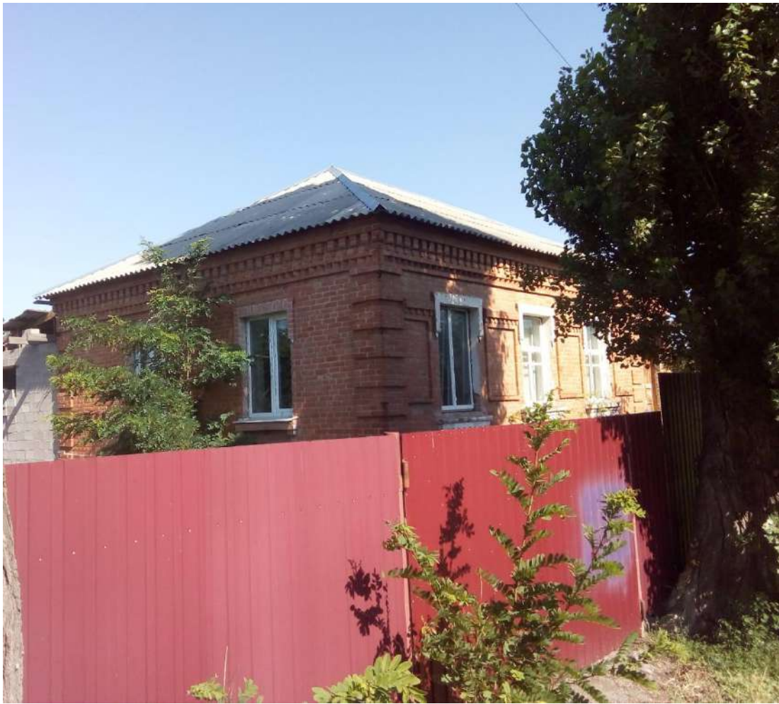
Будинок житловий вул. Бобринецький шлях, 74
