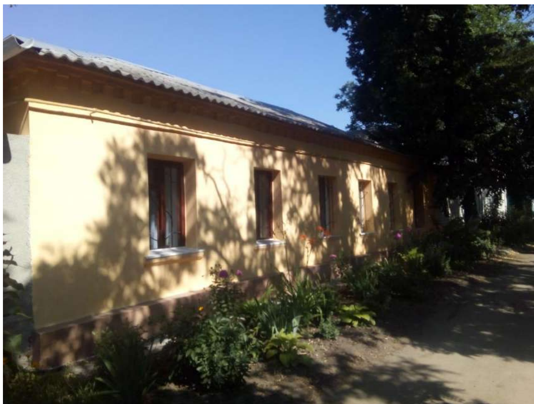
Будинок житловий вул. Бобринецький шлях, 6
