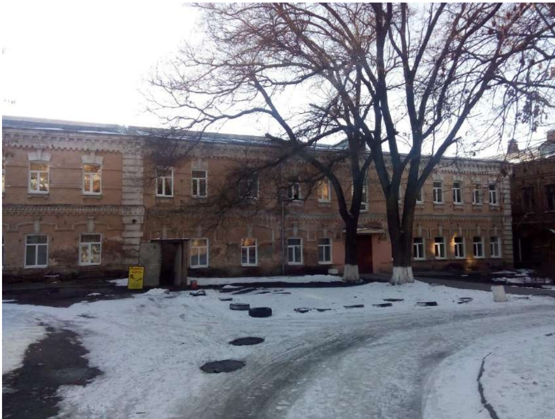
Будинок житловий вул. Архітектора Паученка, 38
