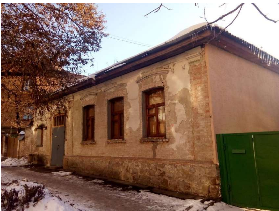
Будинок житловий вул. Архітектора Паученка, 62
