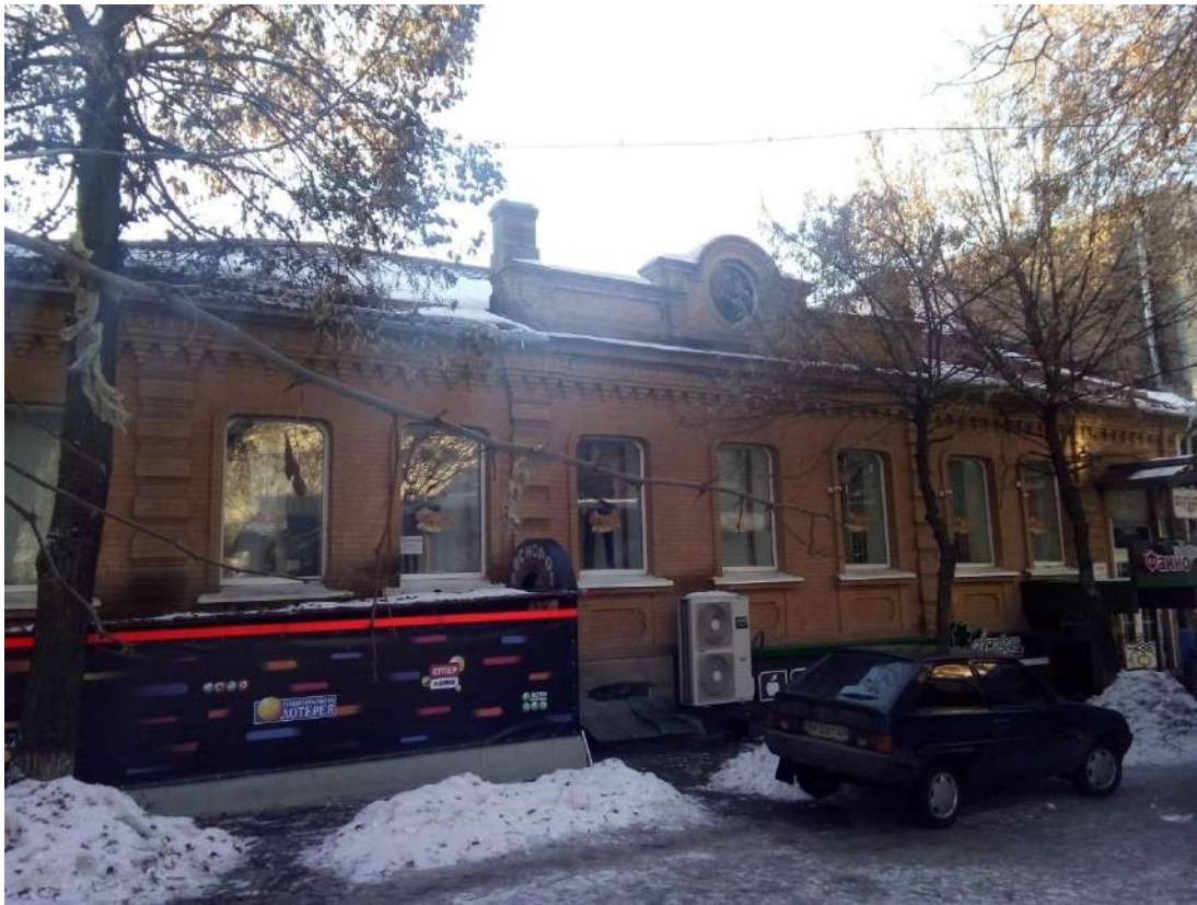
Будинок житловий вул. Архітектора Паученка, 36
