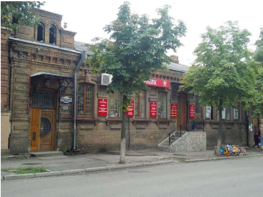
Будинок житловий вул. Арсенія Тарковського, 63-А
