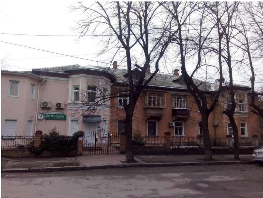
Будинок житловий вул. Архітектора Паученка, 48
