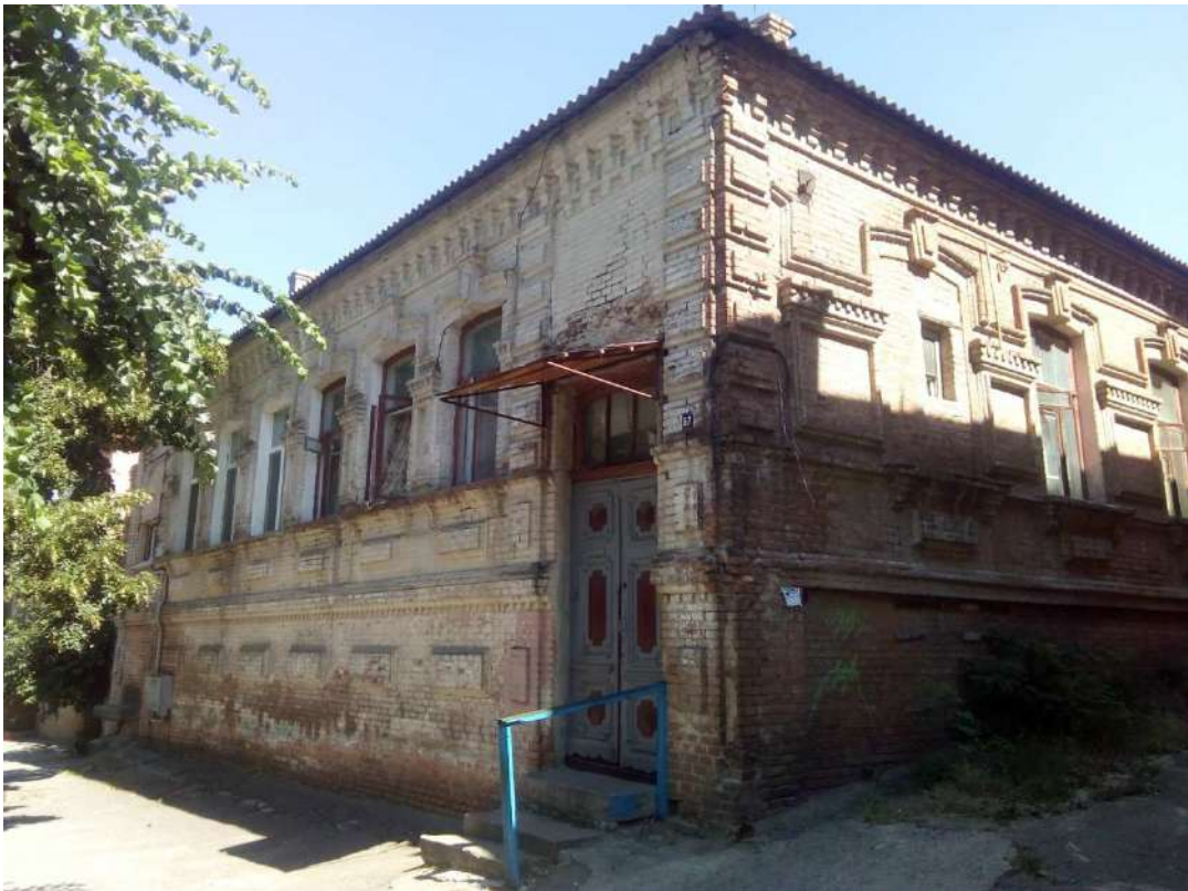
Будинок житловий вул. Архітектора Паученка, 67
