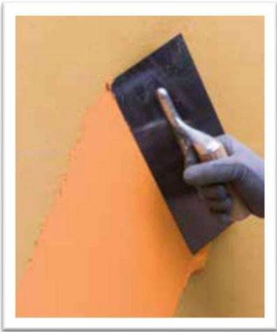
Нанесення першого шару Mapetherm Flex RP
