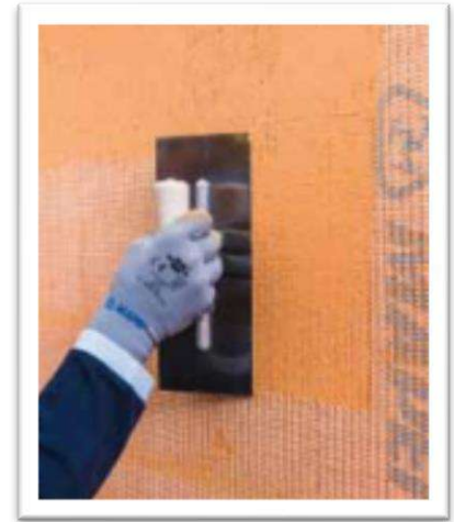
Нанесення другого шару Mapetherm Flex RP
