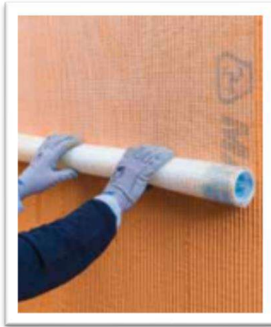
Занурення лугостійкої склосітки Mapetherm Net в свіжий шар Mapetherm Flex RP
