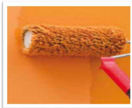
Фінішна обробка поверхні за допомогою нанесення валиком Silancolor Paint Plus поверх Mapetherm Flex RP
