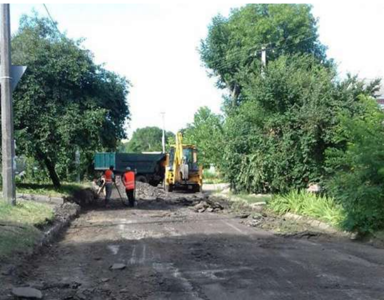
Завершено капітальний ремонт дорожнього покриття на вул. Водоп'янова від Кримської до Чернишевського.
