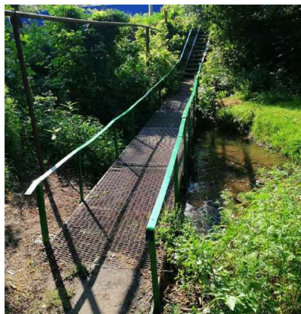
Відремонтовані перила через р.Біанку.
