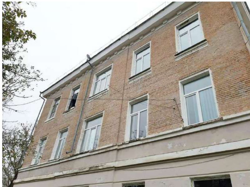
Завершено заміну вікон на енергозберігаючі склопакети в ЗОШ №30.
